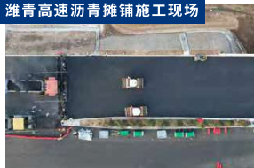
潍青高速沥青摊铺施工现场
